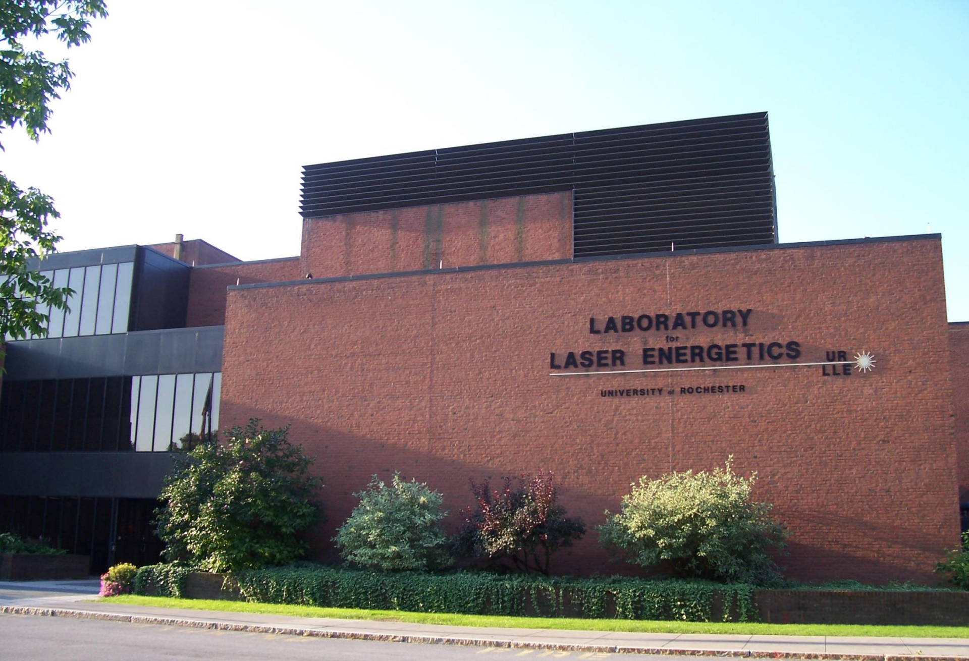
Лаборатория Лазерной Энергетики – главный вход Фото из интернета
